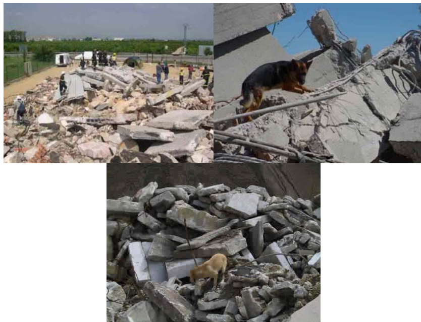
Foto: Zonas de búsqueda de gran dificultad en estructuras colapsadas
